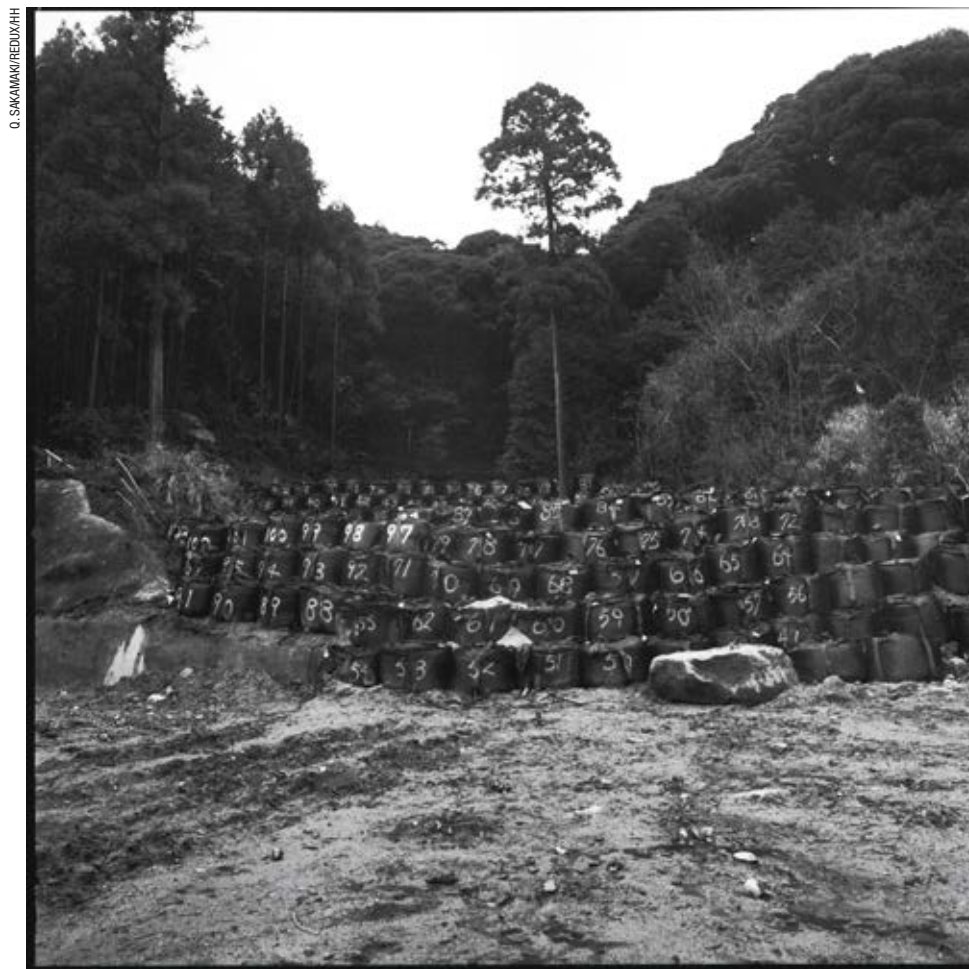
FUKUI Een wal moet water en modderstromen tegenhouden in een gebied met drie kernreactors.
